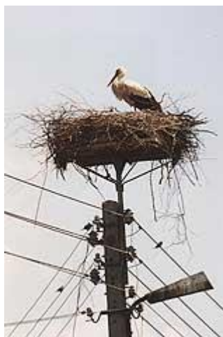
Platforma zamontowana na czynnym słupie energetycznym
