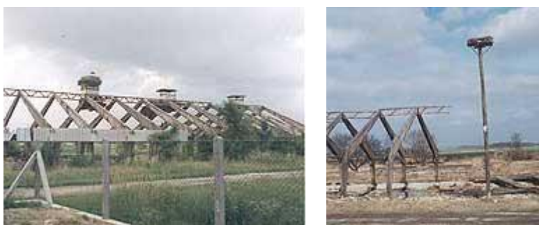
Zamiana gniazda umiejscowionego na starej hali przeznaczony do rozbiórki na słup wolnostojący ustawiony w tym samym miejscu
